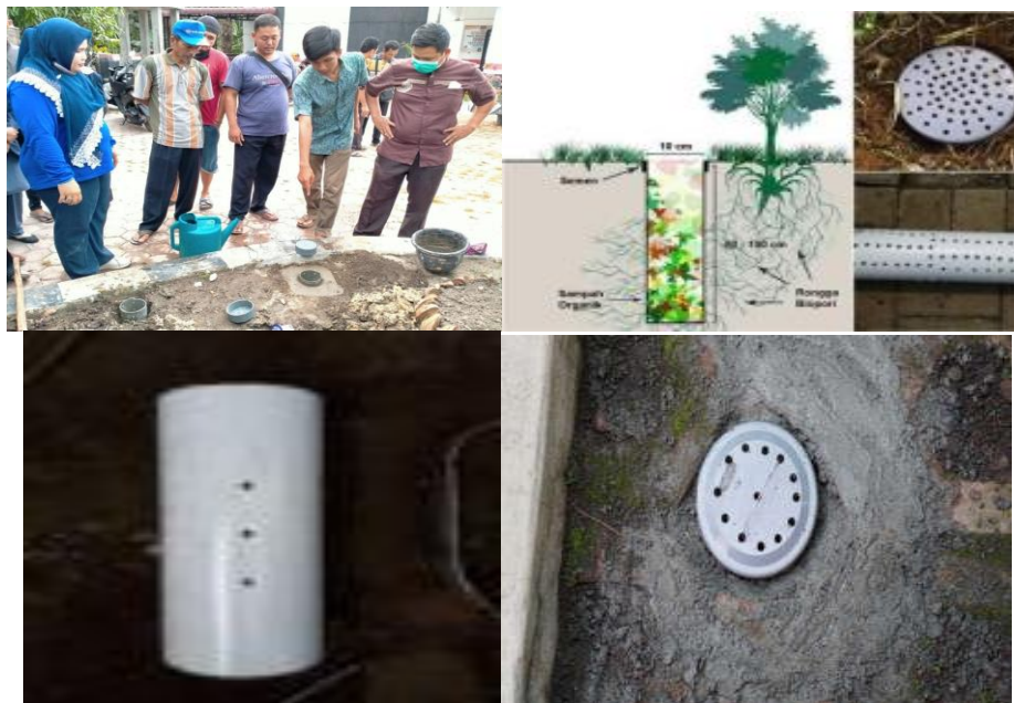
Gambar 5. Sketsa pemasangan pipa Lubang Resapan Biopori
