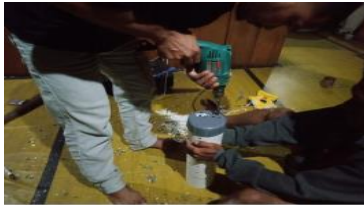
Gambar 1. Pembuatan Lubang Resapan Bipori dengan menggunakan pipa paralon
