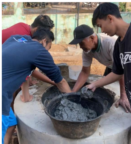
Gambar 2. Kondisi digester biogas sebelum diperbaiki
