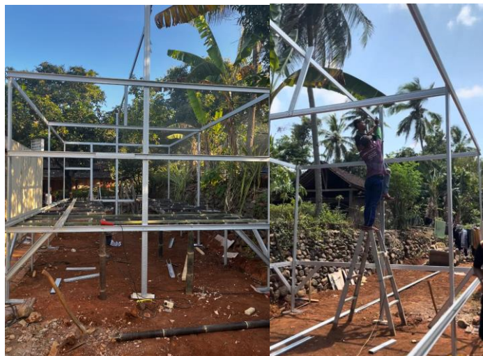
Gambar 3. Proses Pembangunan Rumah Kasa
