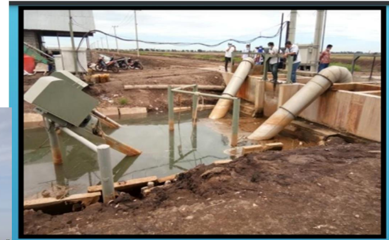
Pompa air bertenaga listrik, generator memutar ulir bor untuk menaikkan air
